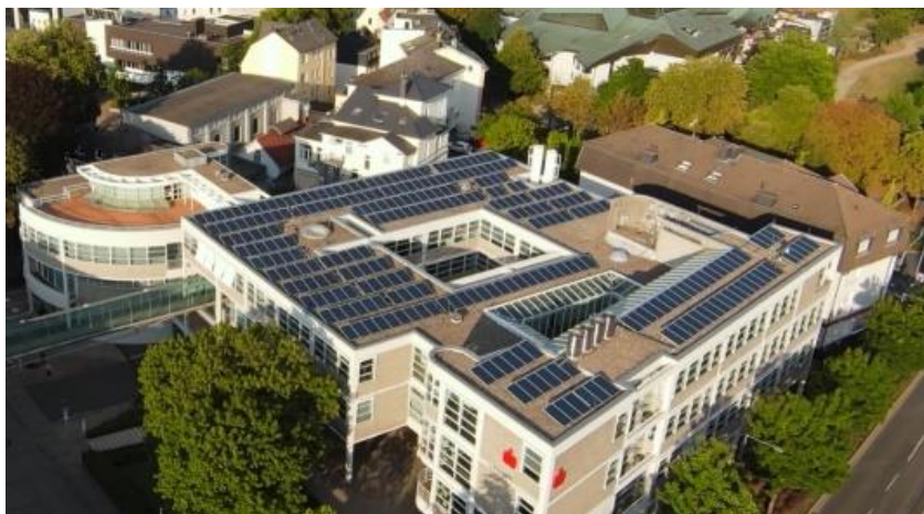
Photovoltaik-Anlage auf dem Dach der Hauptstelle Lüdenscheid, Sauerfelder Straße 11, 58511 Lüdenscheid
